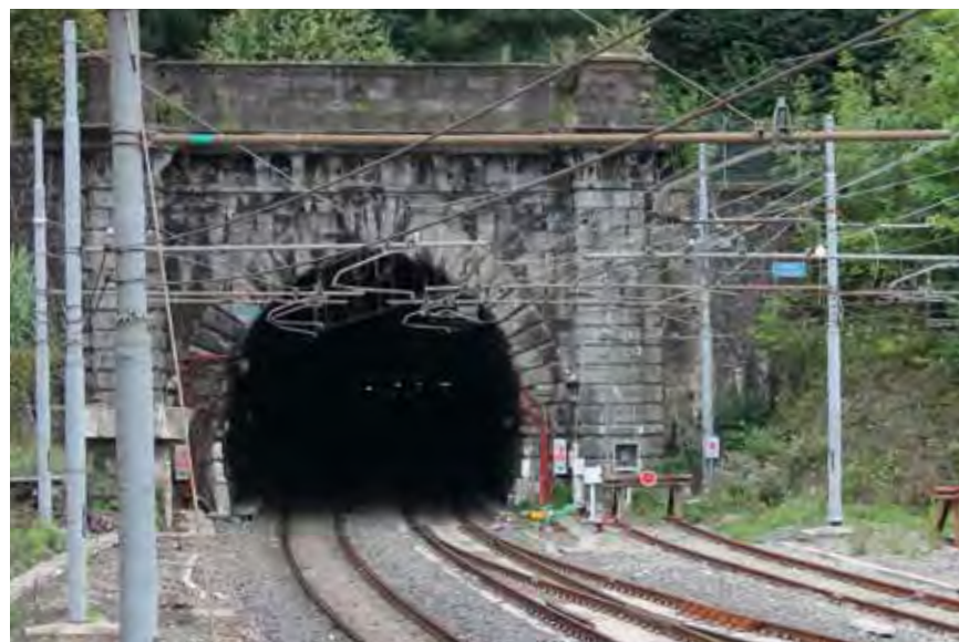
IMBOCCO NORD GALLERIA RONCO
