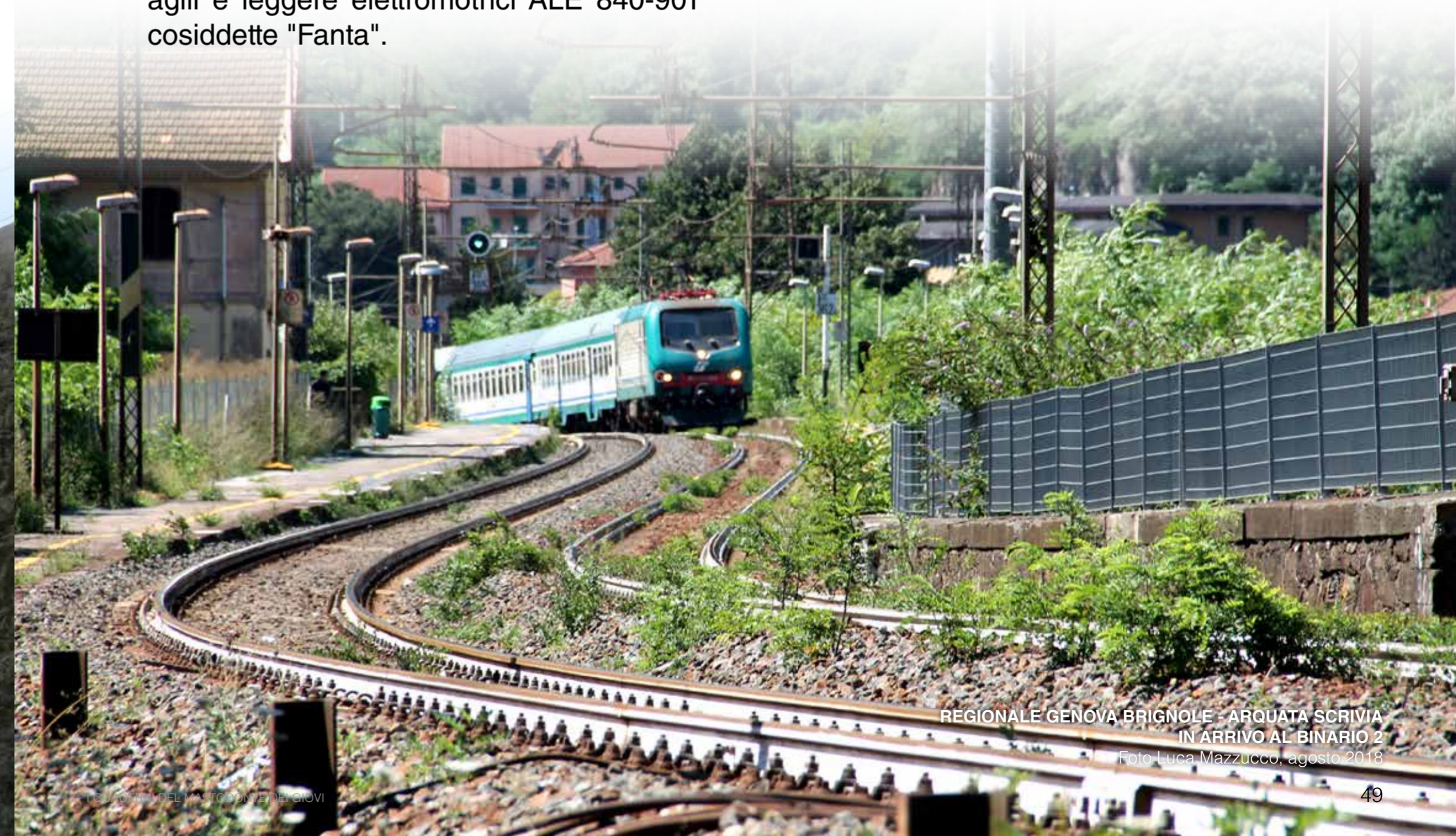
MURAGLIONE CHE SOSTIENE LA FERROVIA A PIANO ORIZZONTALE SULLO SFONDO VIADOTTO DI MIGNANEGO
